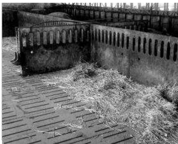
Άχυρο σε μερικώς σχαρωτό δάπεδο
